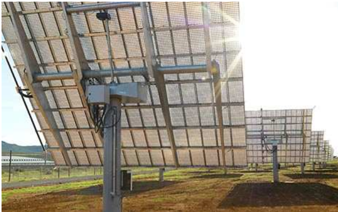
Figuur 10: Solar trackers volgen de zon en worden gebruikt in zonnige landen om de opbrengst van de panelen te verhogen. (bron: treehugger.com)
